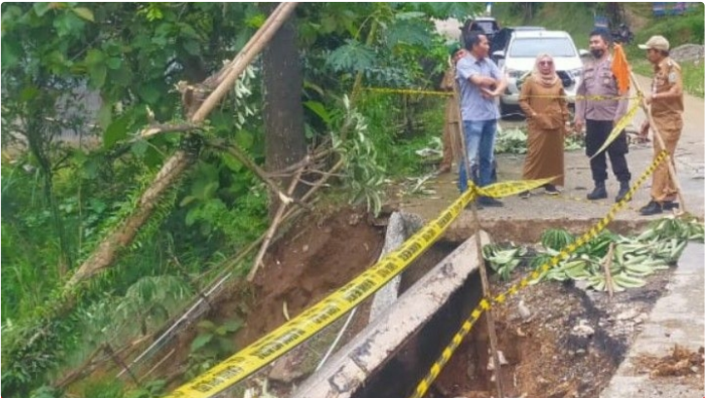
Dinas PU Provinsi Sulawesi-Selatan tinjau Akses jalan poros Provinsi Tabora Tondong Tallasa longsor
